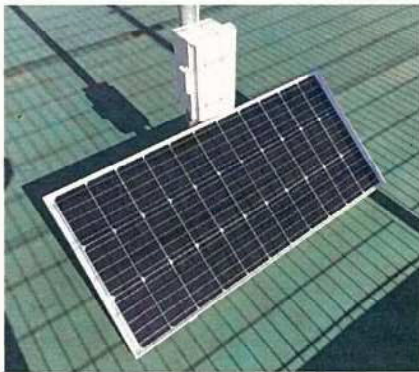
図 5.1.8 ソーラーパネルと蓄電用カーバッテリー
