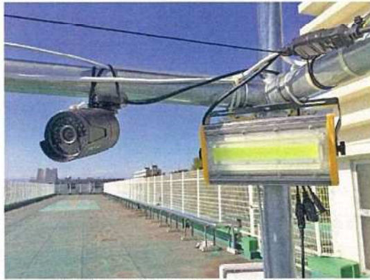
図 5.1.7 監視カメラと LED 投光器
