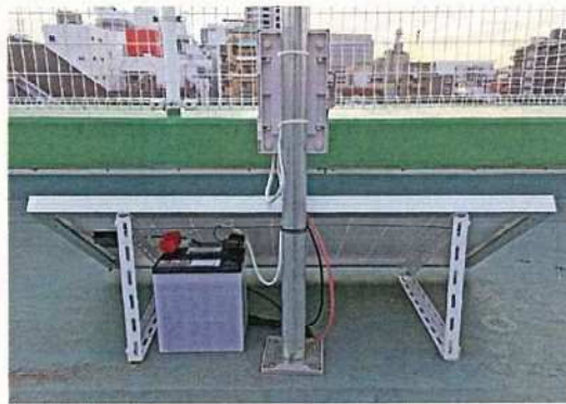
図 5.1.8 ソーラーパネルと蓄電用カーバッテリー
