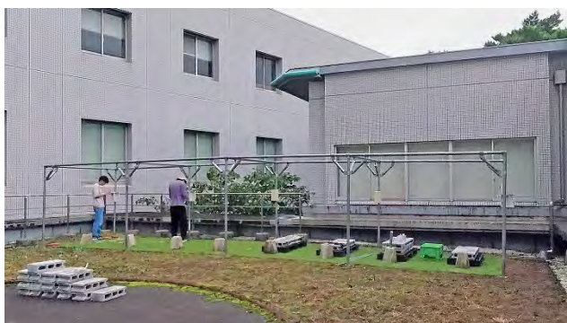
図 6.1.59 図書館屋上施設完成(10月28日)
