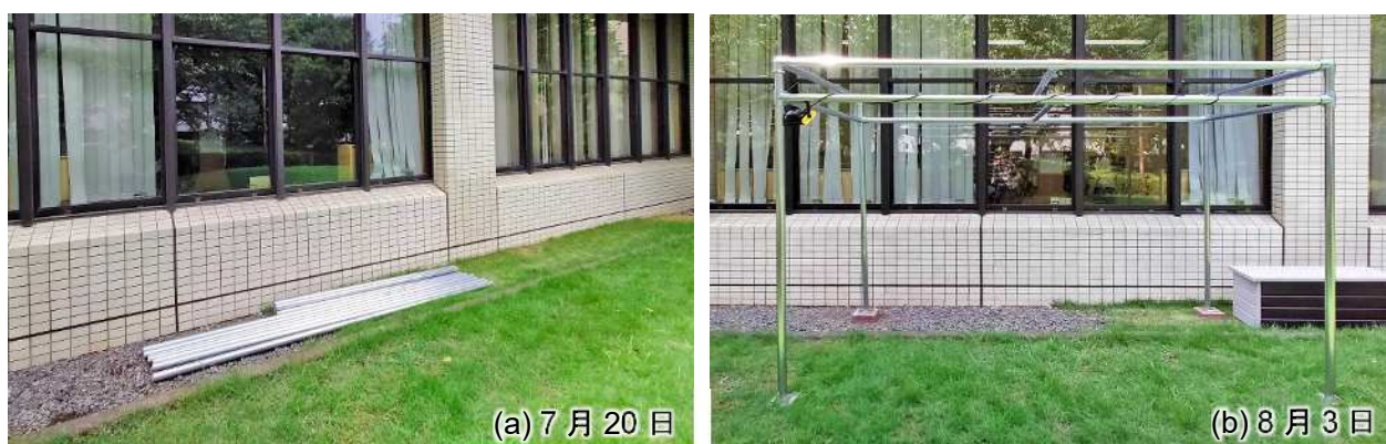
図 5.4 (a)部材の運び込み (b)フレームと収納箱の組立
