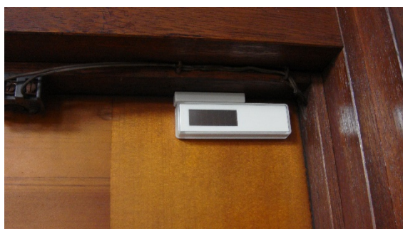
ドア内側にセンサーを設置 図6-5
