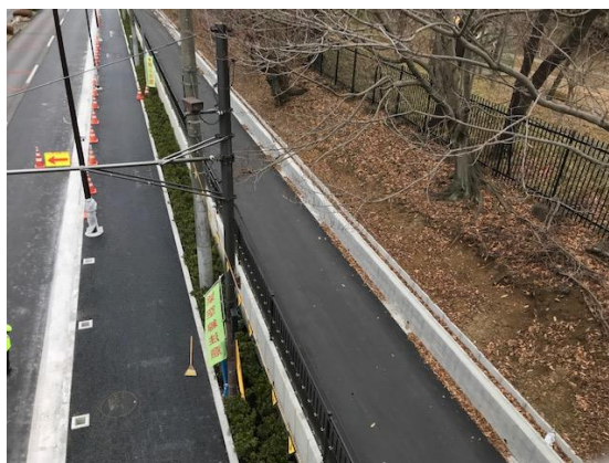
東八道路自転車競技のための副道
