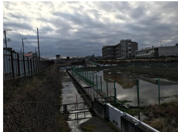
50 mm/時降雨対応整備を進める野川大沢調節池
