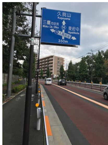
東八道路富士見橋を西側から見る
