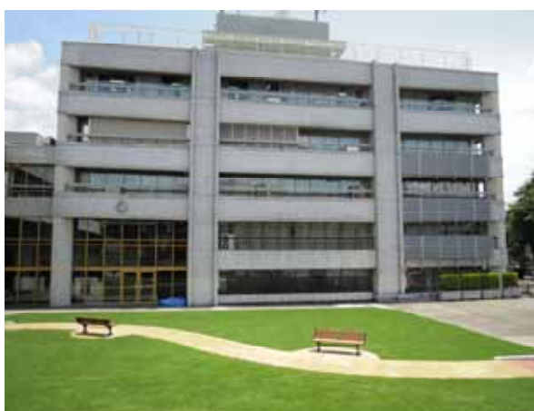
スーパーエコ庁舎(本庁舎)の全景
