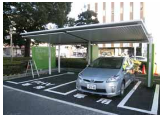
太陽光発電で電気を供給する PHV 用充電スタンド (市役所内敷地) (資料 10)
