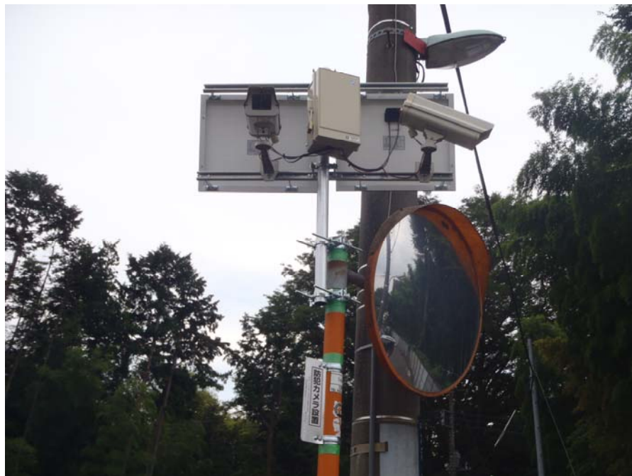
北側から南方向を撮影。
