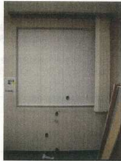
写真 4. 3. 25~26 耐水紙仕様取り付け状況 会議室の小さい窓は1枚の幅が約 450mm の標準的な割付とした。窓下に温度測定器 が設置されている。
