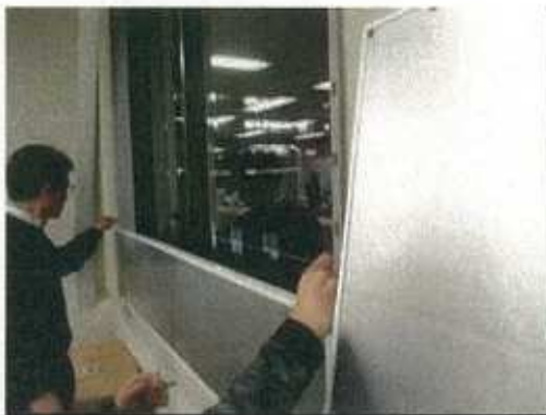
写真 4.3.36～37 面ファスナー式設置状況
