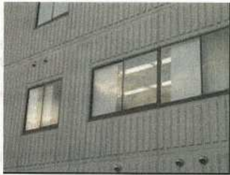
写真 4. 3. 25~26 耐水紙仕様取り付け状況 会議室の小さい窓は1枚の幅が約 450mm の標準的な割付とした。窓下に温度測定器 が設置されている。
