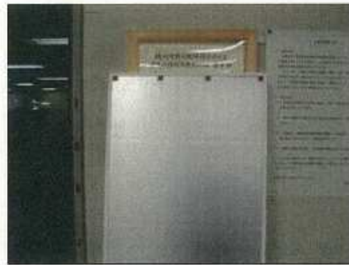
写真 4.3.36～37 面ファスナー式設置状況
