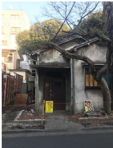
写真⑤ 撤去後空き家
